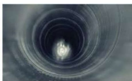
Alle soorten luchtbehandelingskanalen
